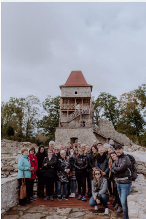
Im Hintergrund die renovierte Burgruine in Stara Kamienica
